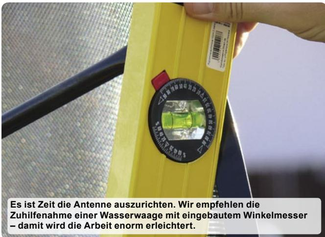
Es ist Zeit die Antenne auszurichten. Wir empfehlen die Zuhilfenahme einer Wasserwaage mit eingebautem Winkelmesser – damit wird die Arbeit enorm erleichtert.
