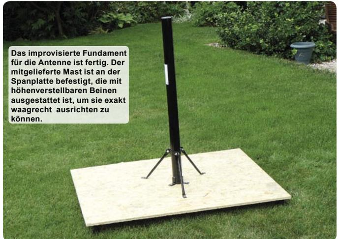
Das improvisierte Fundament für die Antenne ist fertig. Der mitgelieferte Mast ist an der Spanplatte befestigt, die mit höhenverstellbaren Beinen ausgestattet ist, um sie exakt waagrecht ausrichten zu können.
