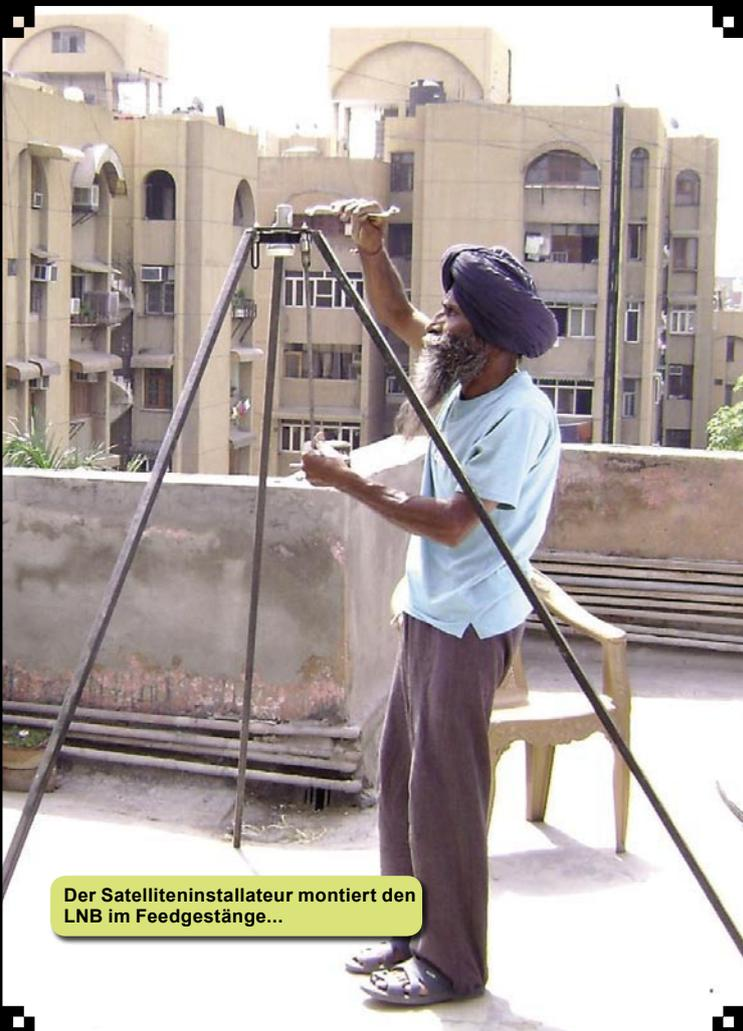
Der Satelliteninstallateur montiert den LNB im Feedgestänge...
