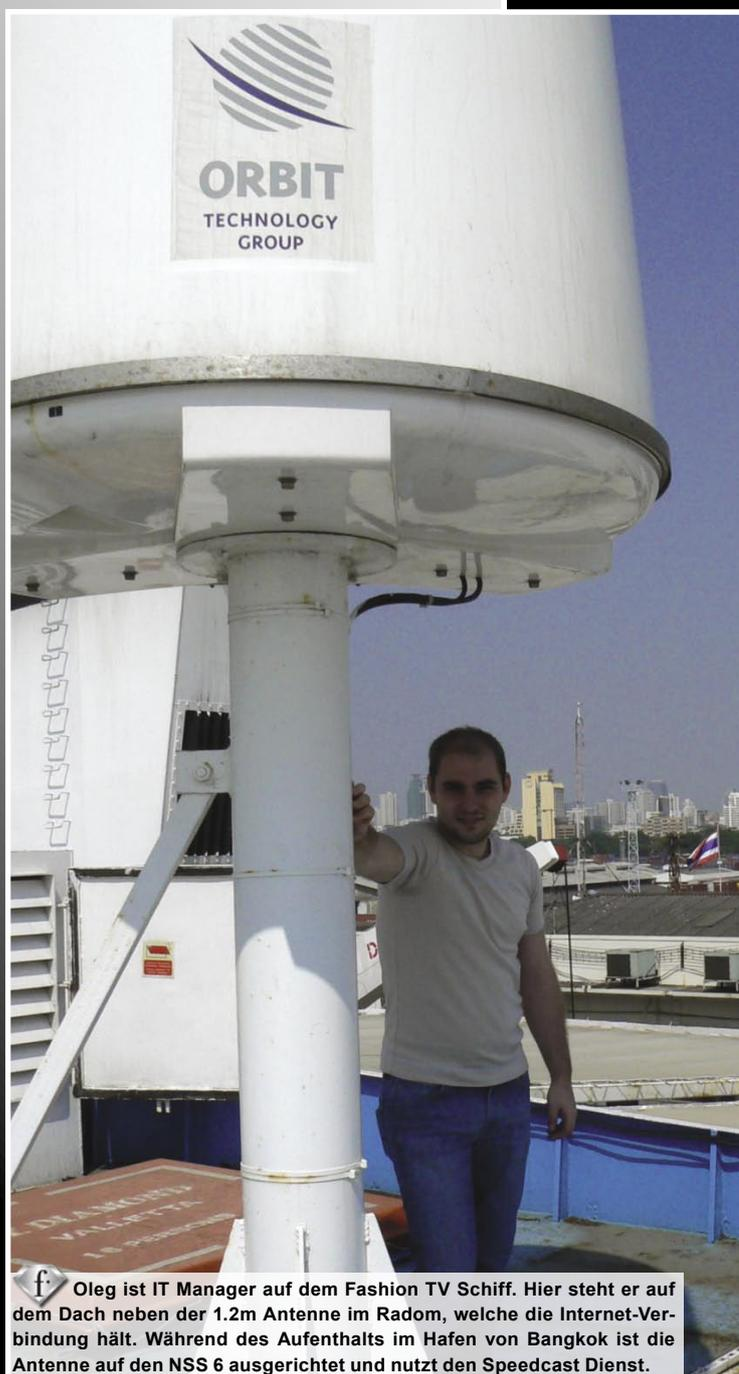
Oleg ist IT Manager auf dem Fashion TV Schiff. Hier steht er auf dem Dach neben der 1.2m Antenne im Radom, welche die Internet-Verbindung hält. Während des Aufenthalts im Hafen von Bangkok ist die Antenne auf den NSS 6 ausgerichtet und nutzt den Speedcast Dienst.
