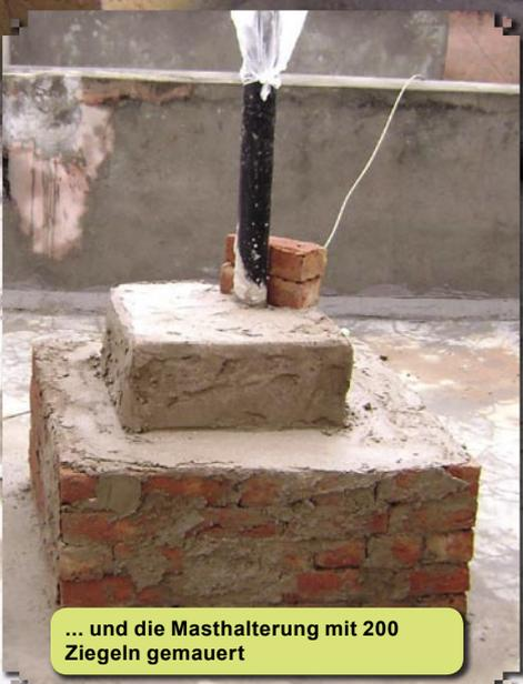
... und die Masthalterung mit 200 Ziegeln gemauert
