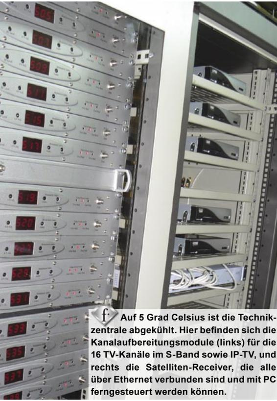
**f** Auf 5 Grad Celsius ist die Technikzentrale abgekühlt. Hier befinden sich die Kanalaufbereitungsmodule (links) für die 16 TV-Kanäle im S-Band sowie IP-TV, und rechts die Satelliten-Receiver, die alle über Ethernet verbunden sind und mit PC ferngesteuert werden können.
