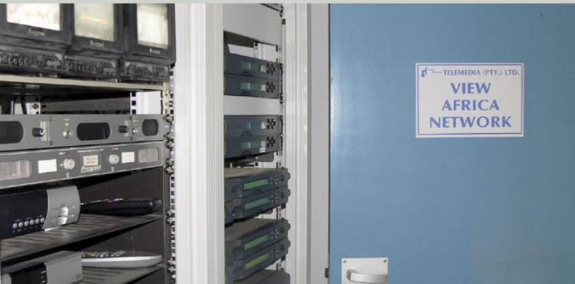
و هنا قلب باقة View Africa شاشات العرض و أجهزة الرئيسيفر على الكابينة إلى اليسار بينما الكابينة على اليمين بها العديد من فتحات أجهزة التشفير لمختلف القنوات ، و على وضع خطوات توجد قنوات البث المباشر للعديد من القنوات تدار من الاستديو القريب من هنا .
