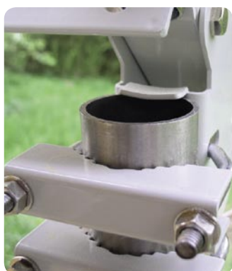
Pemasangan actuator EDON di atas tiang
