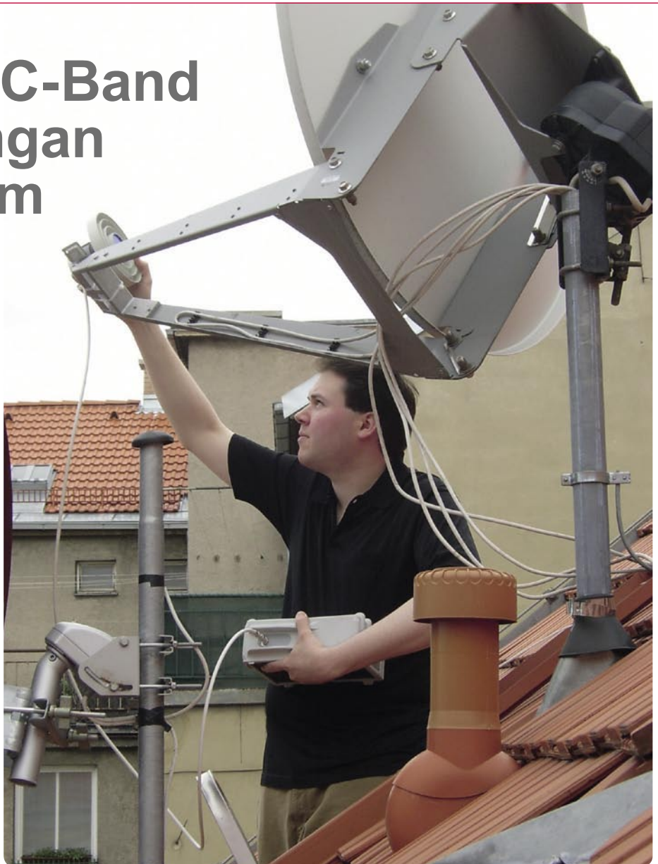
Thomas Haring mengatur feed C-band pada piringan antena offset 1,2m sambil memeriksanya dengan bantuan signal analyzer Prodig-5, yang juga dibahas dalam edisi ini |
