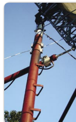
Sebuah actuator dilas di tiang untuk menggerakkan antenna
