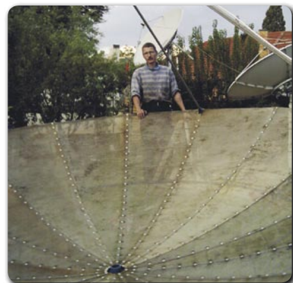
Pemasangan reflektor telah selesai. Dapat dinaikkan ke posisinya
