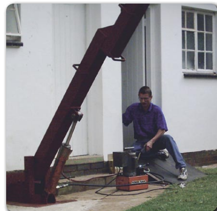
Sebuah hidrolik untuk menaikkan antena ke posisi vertikal
