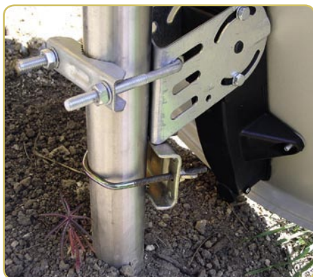
Sepasang penjepit tambahan untuk menstabilkan piringan pada saat pengaturan
