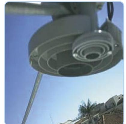
Beginilah penerimaan simultan untuk sinyal C dan Ku-band dicapai. Karena antenna prime focus maka digunakan feed beralur untuk LNB Ku-band.
