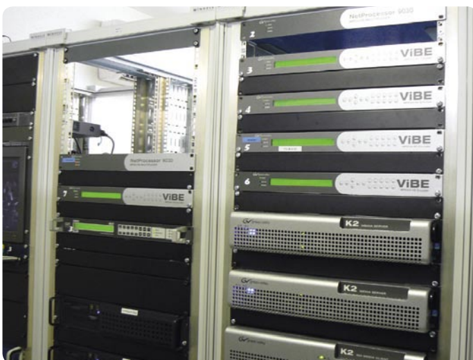
▲ Siaran diproses di sini dalam MPEG-4 dan disalurkan ke Uplink.
