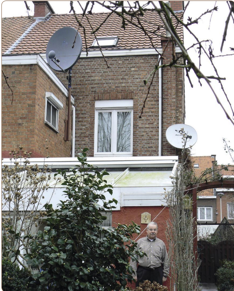
Antena 1,2m bermotor tersembunyi di balik ranting di kiri atas. Antena multifeed lainnya dipasang di dinding luar dan digunakan untuk penerimaan saluran standar. Leo Stouten berdiri di tamannya.
