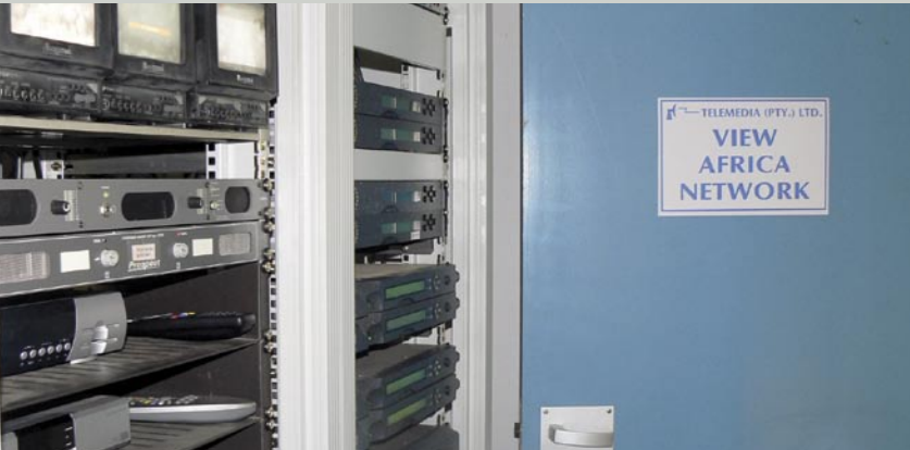
▲ Di sinilah pusat dari paket saluran View Africa: monitor penerimaan dan receiver dapat ditemukan di lemari dari kiri ke kanan tempat berbagai slot encoding untuk semua saluran yang berbeda. Feed untuk banyak saluran yang dihasilkan dari studio yang berdekatan.
