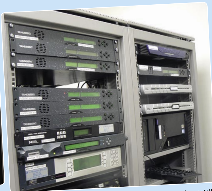
Sinyal diproses di sini. Slot Tandberg untuk pengoperasian satelit. Slot untuk link gelombang mikro ke SENTECH, penyedia layanan Afrika Selatan untuk penyaluran sinyal tersebut.
