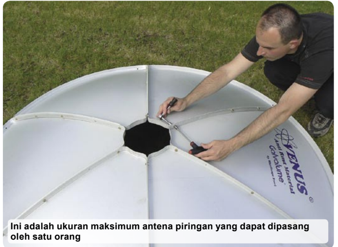
Pinggir dari bagian ditebuk pada satu sisi untuk meningkatkan kekokohan
