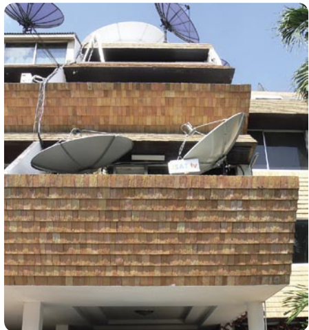
Jon construyó su compañía en su vieja residencia de vacaciones cerca del Camino de Sukhumvit. Todo el espacio disponible está ocupado con platos de satélite para poder mostrar fácilmente a sus clientes que canales pueden recibirse.
