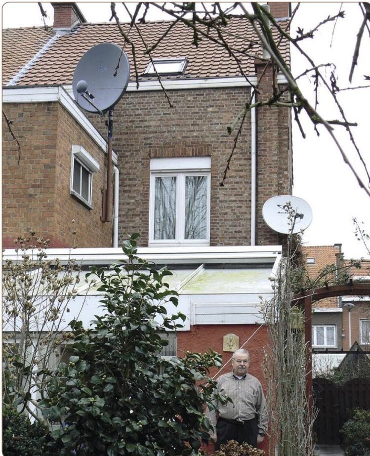
L'antenne motorisée de 1,2 mètres est dissimulée derrière les branches en haut à gauche. Une autre antenne à sources multiples est érigée sur le mur extérieur et sert à capter les stations courantes. Léo Stouten dans son jardin.
